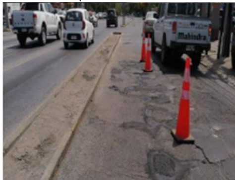
Bacheo Superficial Asfáltico
